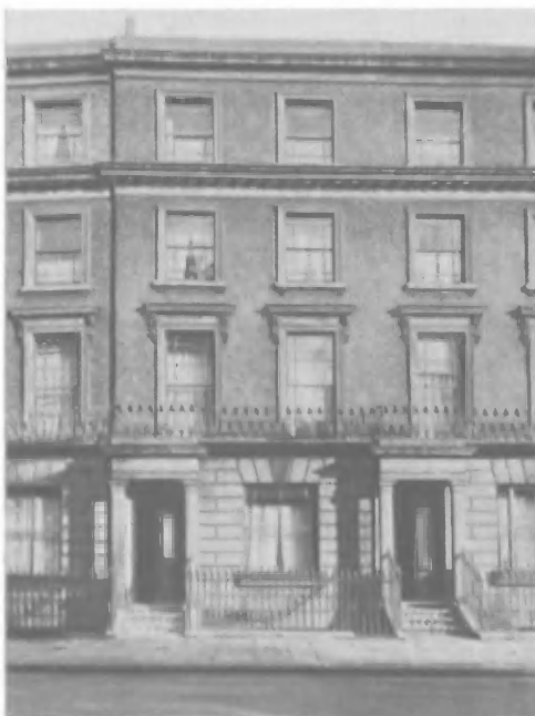
Дом в Лондоне (122, Риджентс-парк-род), в котором жил Энгельс с сентября 1870 по октябрь 1894 г.
